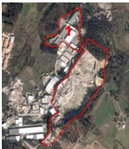
figura 2 - área total de implementação das instalações centrais do grupo dst (área delimitada pela linha vermelha)
