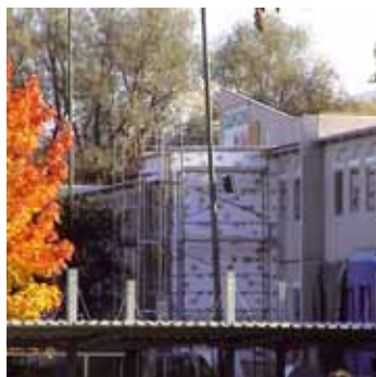
Einbau Wärmedämmung Stiegenhaus
