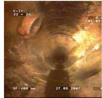
Die Kamerabefahrung offenbarte
