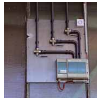
Schließlich gelangt der Rauch in den zentralen Detektor ...
