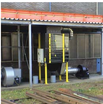
Neue Absaug/Filteranlage
