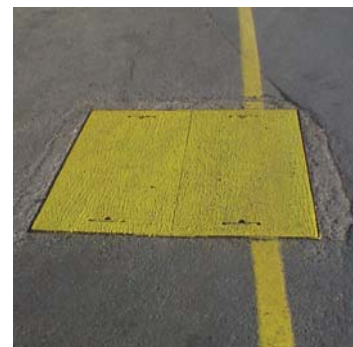
Antirutsch-Anstrich für Kabelschacht-Abdeckungen
