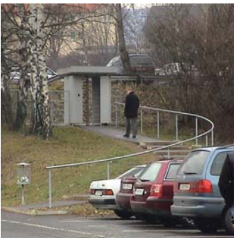
...sowie Zugang "Parkplatz II" kann Verletzungen durch "Sturz und Fall" vorbeugen.
