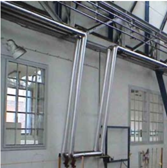
Rohrleitungsisolierungen
