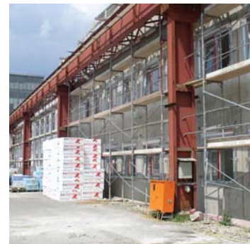
Die wärmetechnische Sanierung des Bürotraktes BG 8/9
