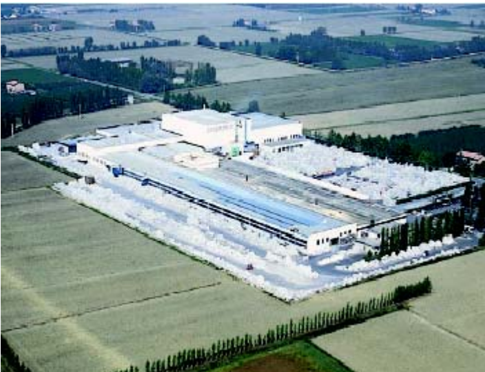
Foto 18: Veduta aerea dello stabilimento
