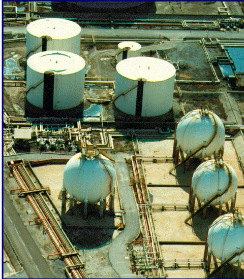
Figura 3: almacenamiento de productos en Refinería.
