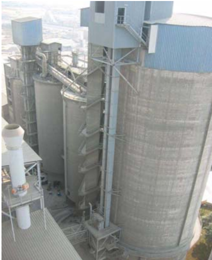
Silos de cemento
