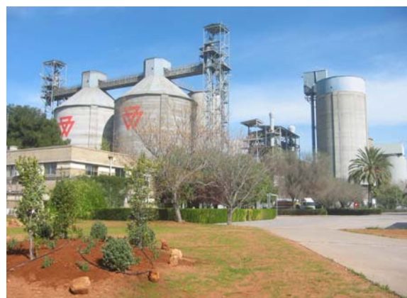
Fábrica Alcalá de Guadaíra
