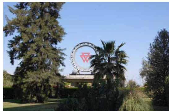
Fábrica Alcalá de Guadaíra
