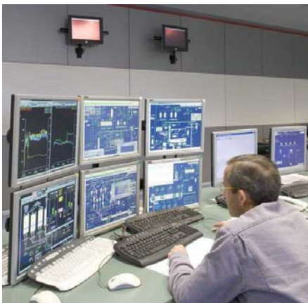
Sala de control
