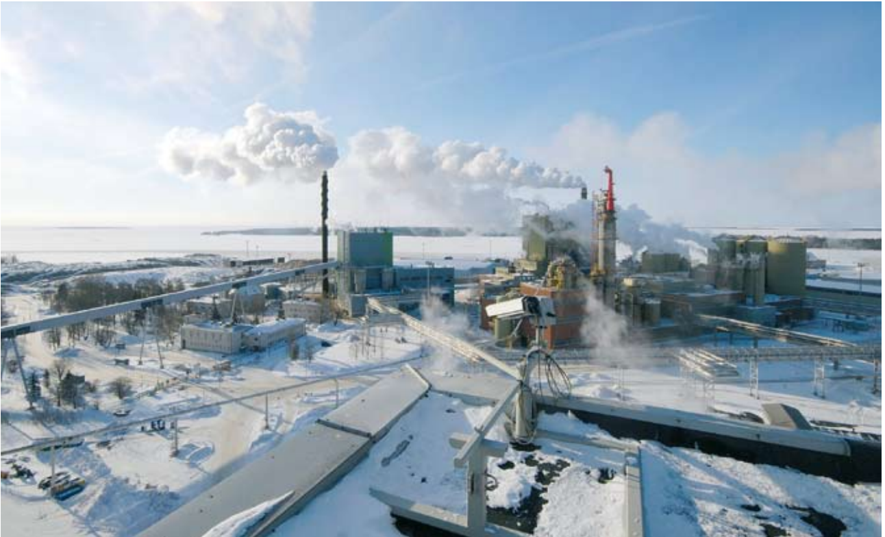
Sellutehtaan hajuhaitat on minimoitu polttamalla laimeat ja väkevät hajukaasut soodakattilassa
