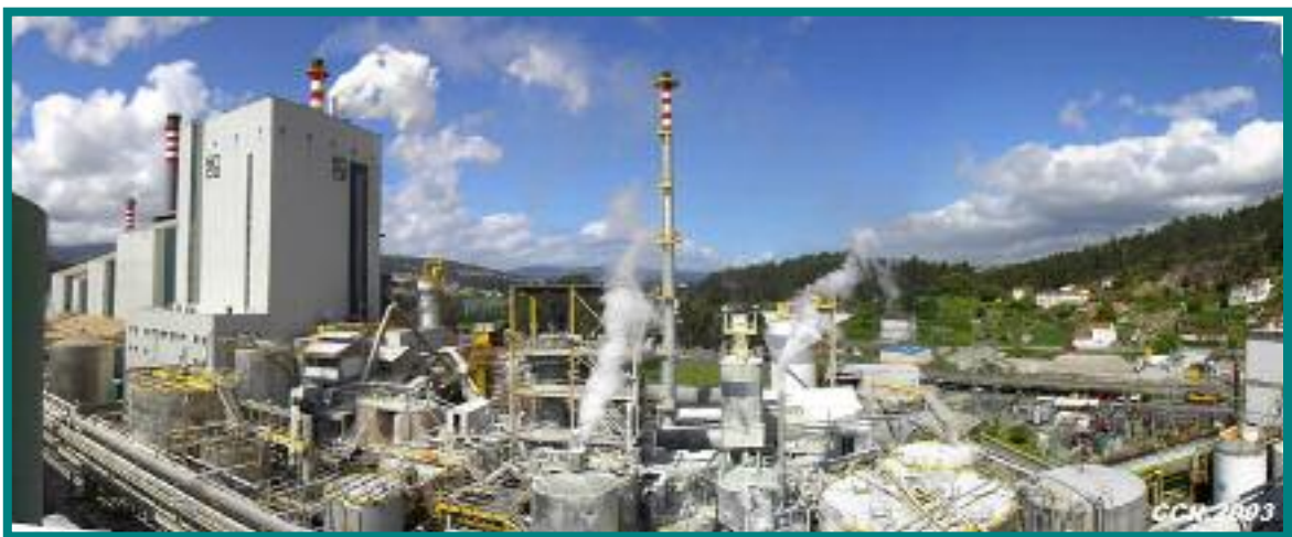
Area de generación de energía y recuperación de productos químicos con los cuatro focos de emisión
