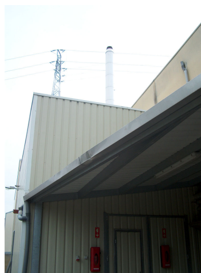
Figura 16 – Chaminé da caldeira a gás natural
