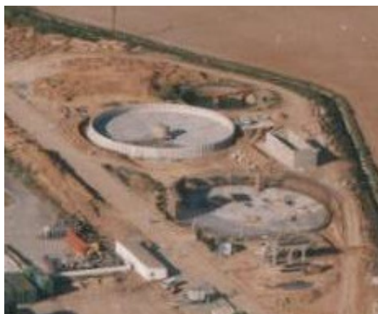
INICIO OBRA DEPURADORA AÑO 1996 / 1997
