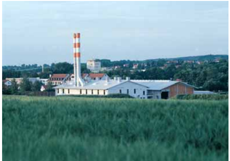
Das Biomasse-Heizkraftwerk Pfaffenhofen: Es liefert umweltfreundlichen Strom, Dampf, Fernwärme und Kälte.
