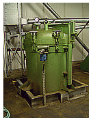
Abb. 6 und 7: Rapsöl - Schnecken- presse und Ölfilteranlage
