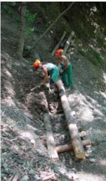
Aménagement d'un chemin pour la stabilisation d'une pente, Italie. (© Photo Azienda Regionale delle Foreste).
