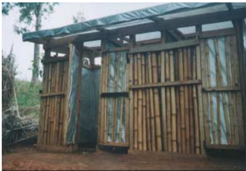
PHOTO 1 : Bloc de latrines temporaire dans un site de déplacés de la province de Bururi
