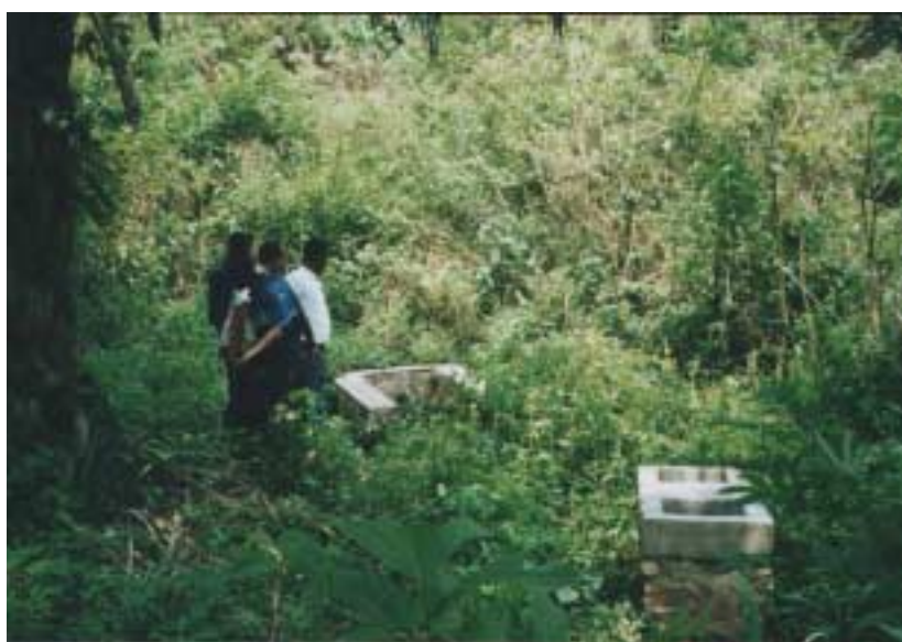
PHOTO 2 : Dégradation d'une source aménagée 1 an plus tôt, province de Bubanza
