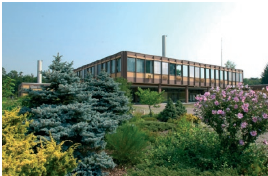
Institute for Transuranium Elements, Karlsruhe (D)
